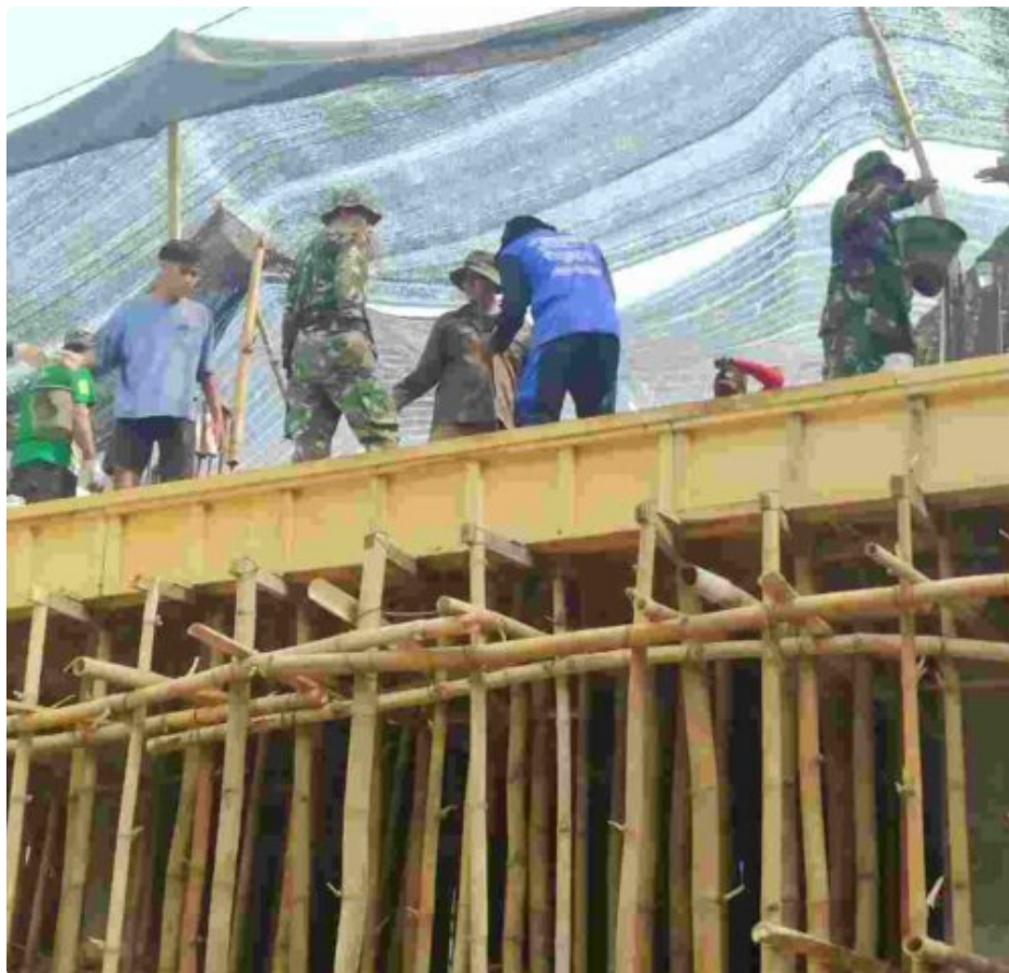
Kegiatan Pengecoran ini dalam rangka pembangunan gedung sekolah MI Alfalah
